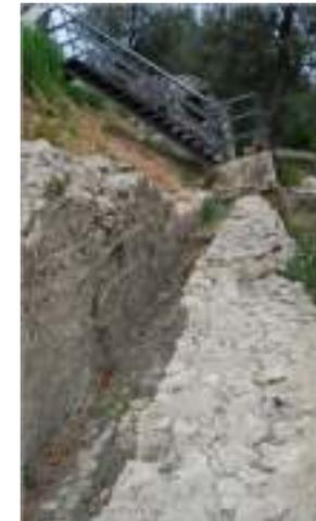
Lungo il versante esposto a nord, infatti si ritrovano delle bocche di immissione dell'acqua costituite da elementi fittili: **due coppi in laterizio accoppiati**, di sezione di diametro circa 18/20 cm. Queste "bocche", sfalsate l'una dall'altra, a distanza di circa 80/100 cm, sono state create nella muratura e fungevano da sbocco all'acqua filtrata dal pendio soprastante.
