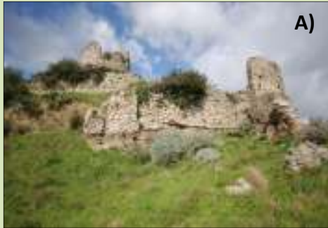
Particolare del muro di contenimento
