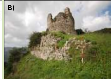
Particolare del Maschio (torre) Centrale e del muro di contenimento
